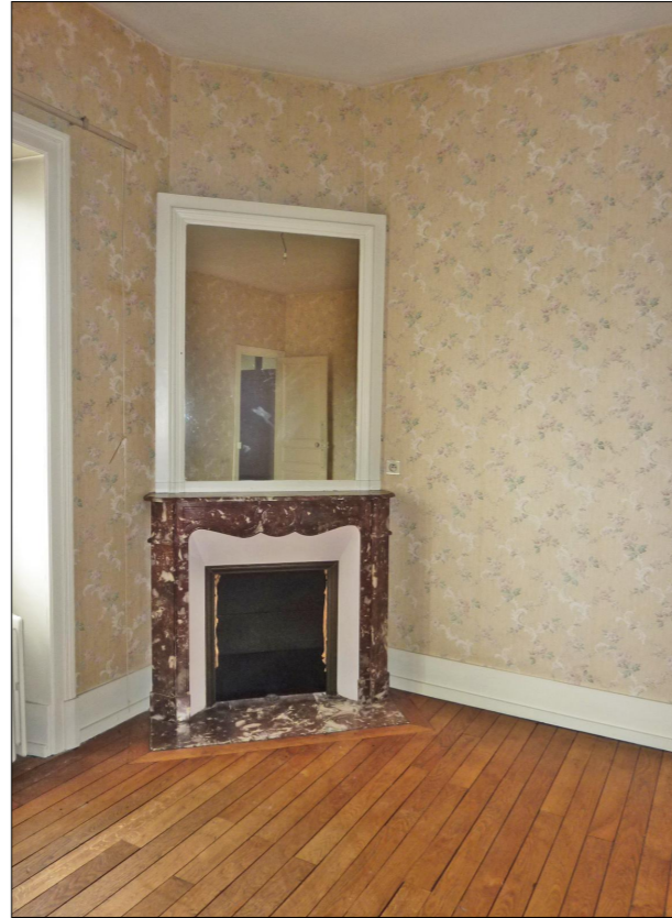
Photo 2 - cheminée à conserver
