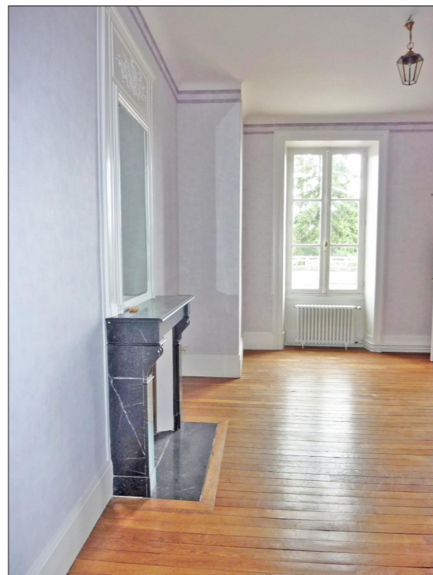
Photo 2 - cheminée à conserver
