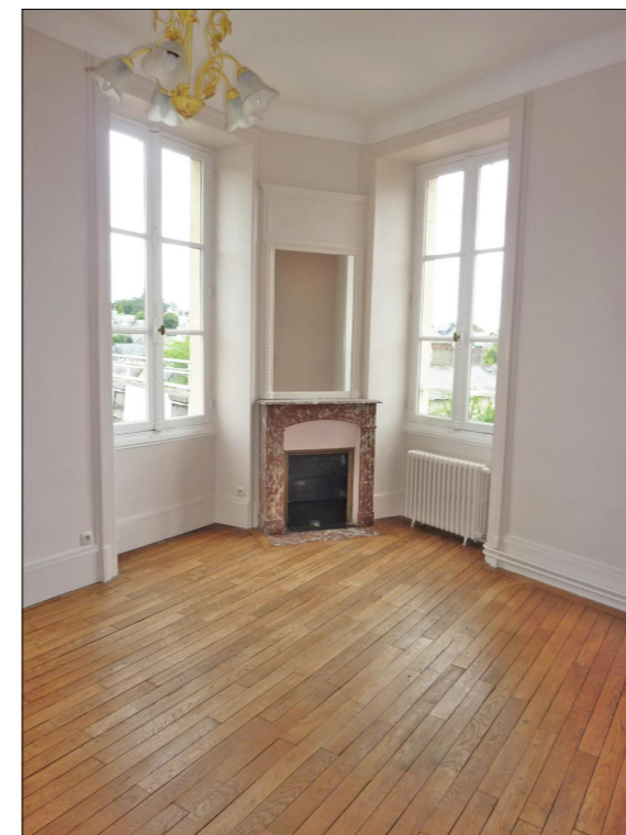
Photo 4 - cheminée à conserver
