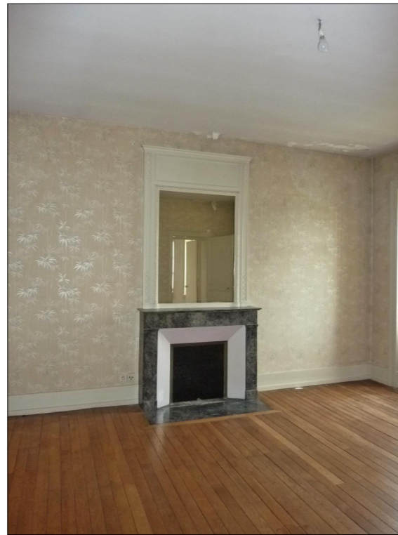
Photo 2 - Cheminée à conserver
